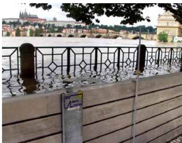
Šedé adaptační opatření - protipovodňová zeď na pražském Smetanově nábřeží
