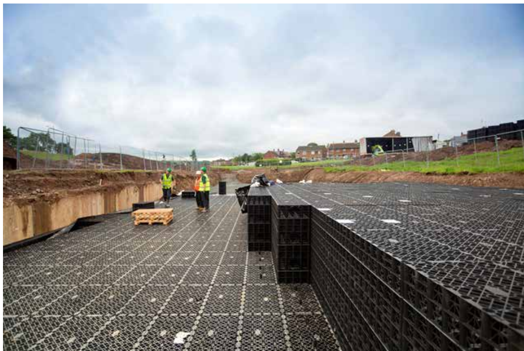
Šedé adaptační opatření - stavba drenážní nádrže umožňující pohlcení přebytečné přívale vody
