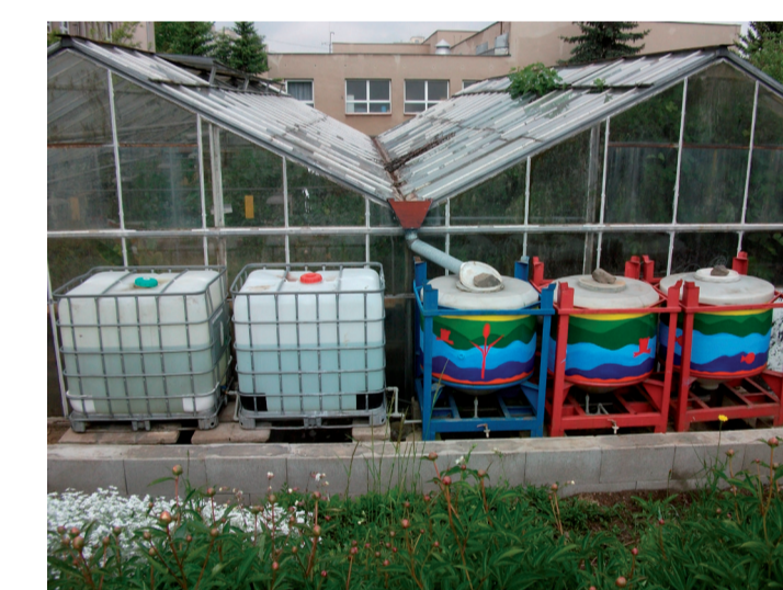
Obr. 4. Příkladem šedého opatření jsou technologie na sběr a využití dešťové vody. Autor: Nadace Partnerství (projekt UrbanAdapt); více na: www.urbanadapt.cz
