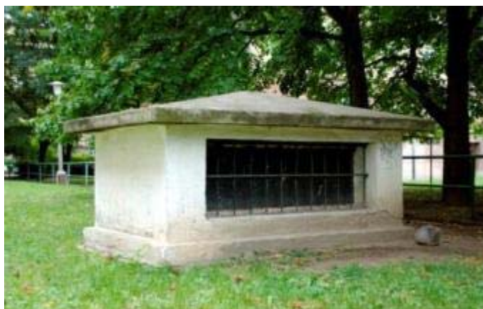
Obrázek 1.21 Povrchový výstup z podzemního úkrytu vybudovaného v 50. letech 20. století v rámci obytného komplexu v Brně – Králově Poli
