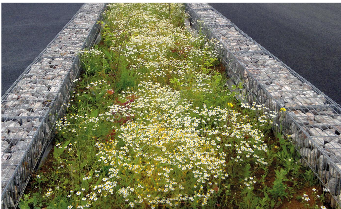
Obrázek 43: Parkoviště stadion, Le Havre (zdroj: http://www.richezassocies.com/files/project_image_777_cropped_fr.jpg )
