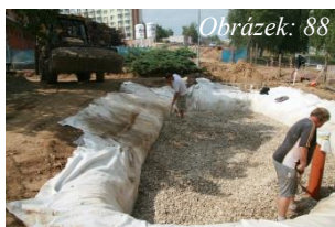
Obrázek: 88 Vsařovací šterková rýha
